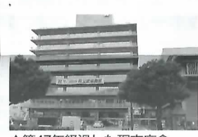
▲築47年経過した現市庁舎
